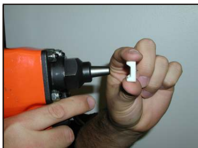
Positionieren des Tack-Mount mit dem Lufthammer
